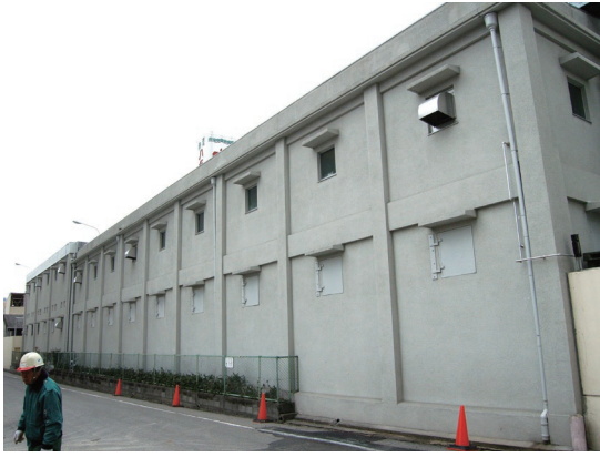
図1 白鷹・北店蔵の外観 (川島智生撮影)
